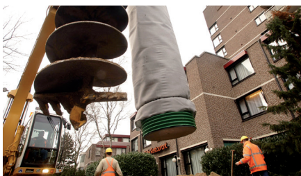
Snel en efficiënt: boren met een mobiele kraan.
